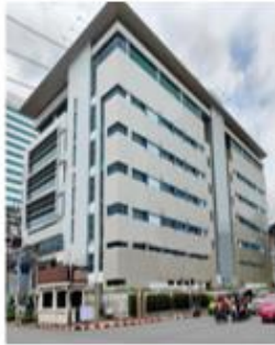
อาคารผู้ป่วยและที่จอดรถ
