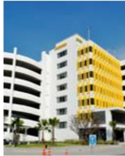
สำนักงาน อาคารจอดรถ
